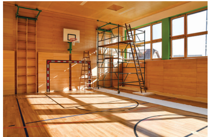
Aufbauarbeiten im hellen, freundlichen neuen Turnsaal
