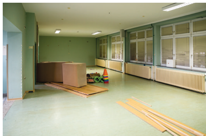
Abbauarbeiten – so kannten wir unseren alten Turnraum.
